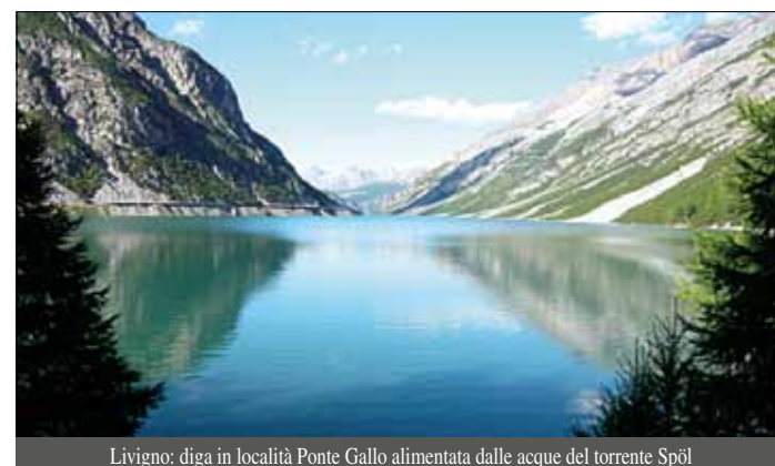
Livigno: diga in località Ponte Gallo alimentata dalle acque del torrente Spöl
