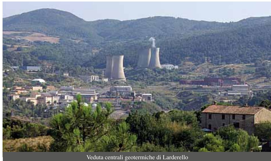
Veduta centrali geotermiche di Larderello
